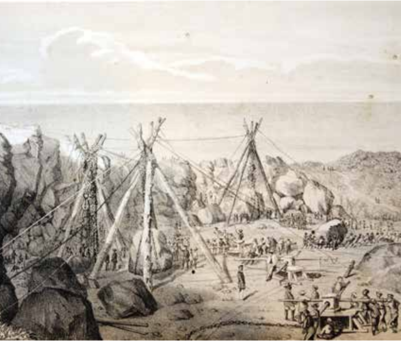
Carrière où s'exploitent les blocs de construction Vue sur les digues et les palans Antoine Louis Roussin - Collection privée : Laurent Hoarau
