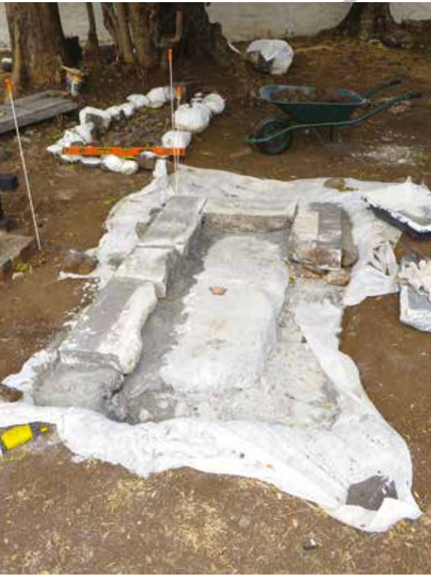
Fig. 4 Repositionnement des pierres de taille constituant le soubassement. Cliché : Confrérie des Gens de la Mer, 2014.
